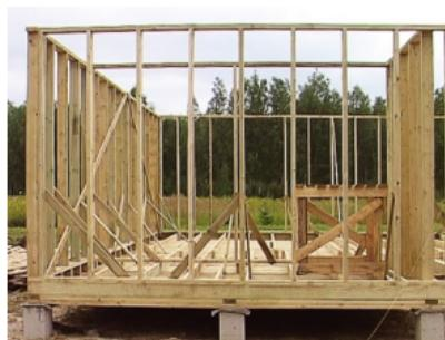
**Рис. 7.14. Готовый деревянный каркас**
