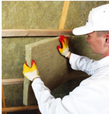
**Рис. 4.5. Укладка второго слоя теплоизоляции**
