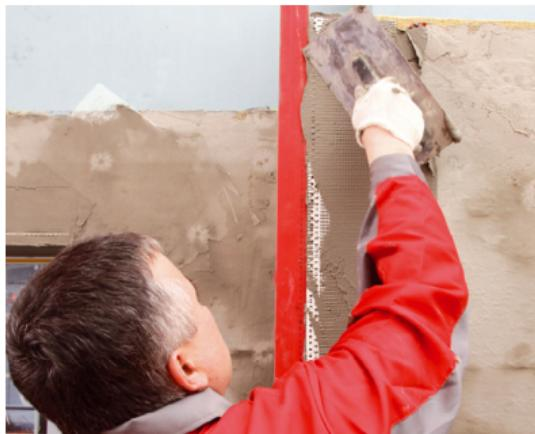
**Рис. 7.30. Армирование базового штукатурного слоя стеклосеткой**
