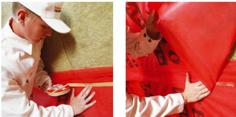
**Рис. 4.7. Проклейка стыков пароизоляционной пленки**
