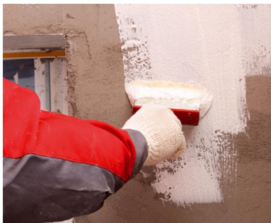
**Рис. 7.31. Грунтовка поверхности**
