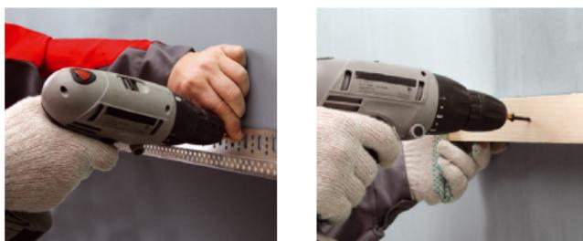
**Рис. 7.20. Установка стартового профиля**
