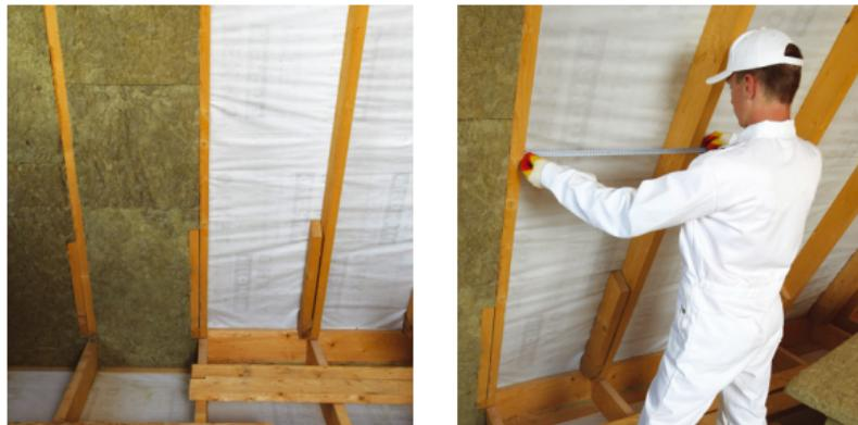
**Рис. 4.3. Подготовленная система для дальнейшего монтажа теплоизоляции**
