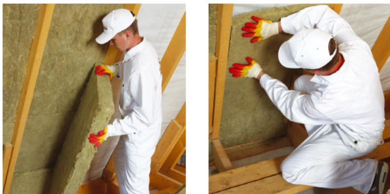
**Рис. 4.4. Монтаж теплоизоляции враспор между стропилами**
