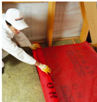
**Рис. 4.14. Монтаж ветро-, влагозащитной пленки**
