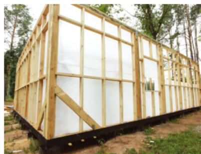
**Рис. 7.15. Монтаж пароизоляционной пленки**
