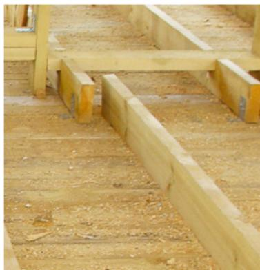
**Рис. 5.2. Подшивка лаг снизу**
