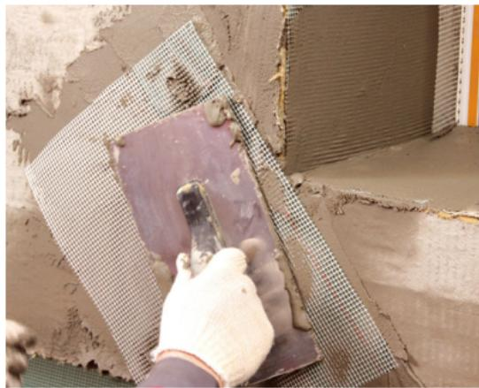
**Рис. 7.28. Процесс усиления угла проема элементом из стеклосетки**
