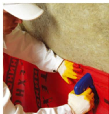
**Рис. 4.6. Укладка и фиксация пароизоляционной пленки**
