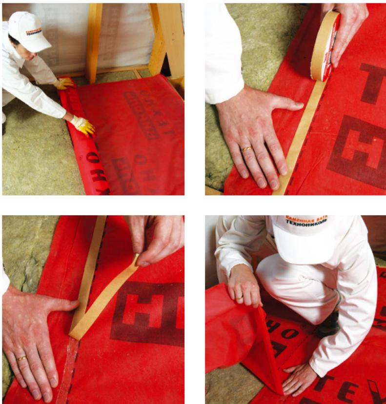
**Рис. 5.4. Монтаж пароизоляционной пленки**
