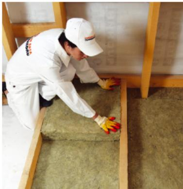
**Рис. 5.3. Монтаж теплоизоляции в распор между лагами**
