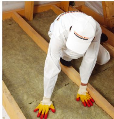
**Рис. 4.13. Монтаж теплоизоляции между балками**
