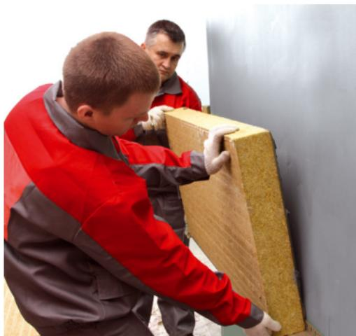
**Рис. 7.24. Приклейка теплоизоляции**
