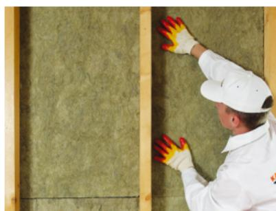
**Рис. 7.16. Монтаж теплоизоляционных плит**
