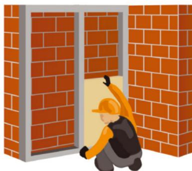
**Рис. 6.10. Монтаж теплоизоляционных плит**
