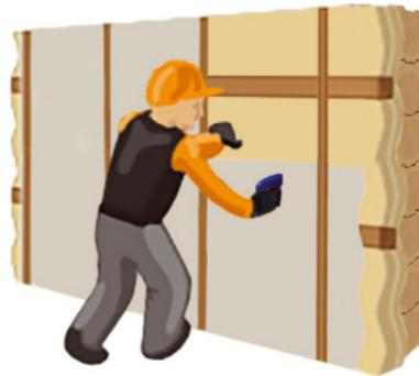
**Рис. 8.4. Монтаж пароизоляции.**
