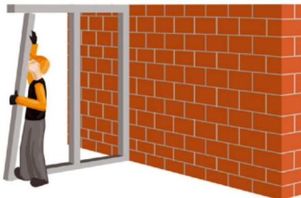
**Рис. 6.3. Установка стоечного профиля**
