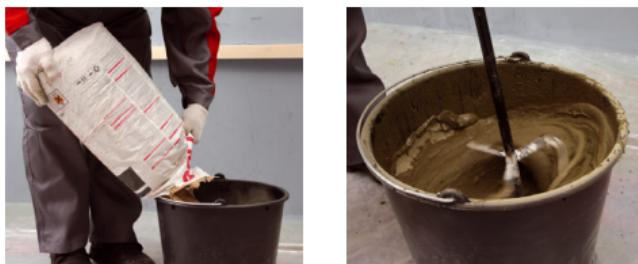
**Рис. 7.21. Процесс приготовления клея**
