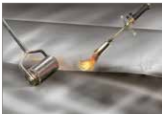
Свободная укладка с сплавлением швов
