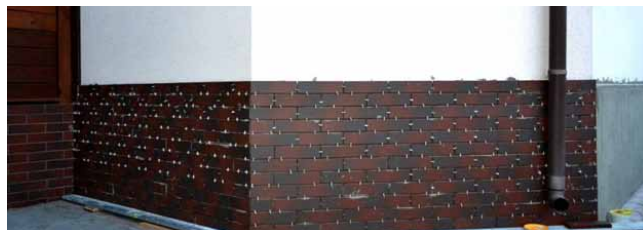
Отделка цоколя плиткой
